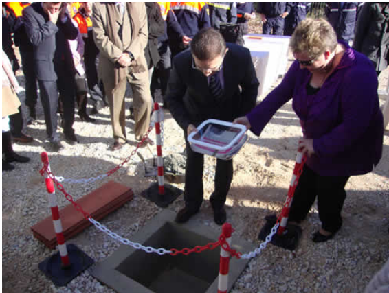
Sr. D. Serafín Castellano Gómez y la Alcaldesa Josefa Ronda, colocan la urna bajo la primera piedra.
